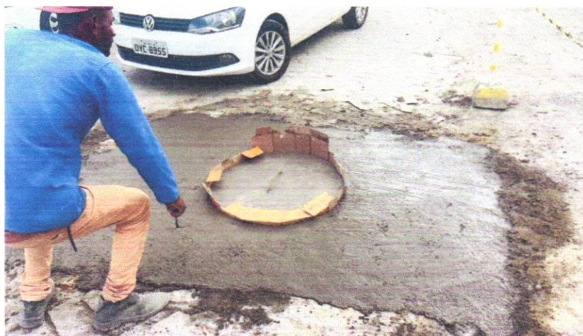
FOTO 02 – PAVIMENTAÇÃO EM CONCRETO, COM ESPESURA DE 7 CM, COM ACABAMENTO FEITO UTILIZANDO ALISADORA DE CONCRETO (HELICOPTERO)
