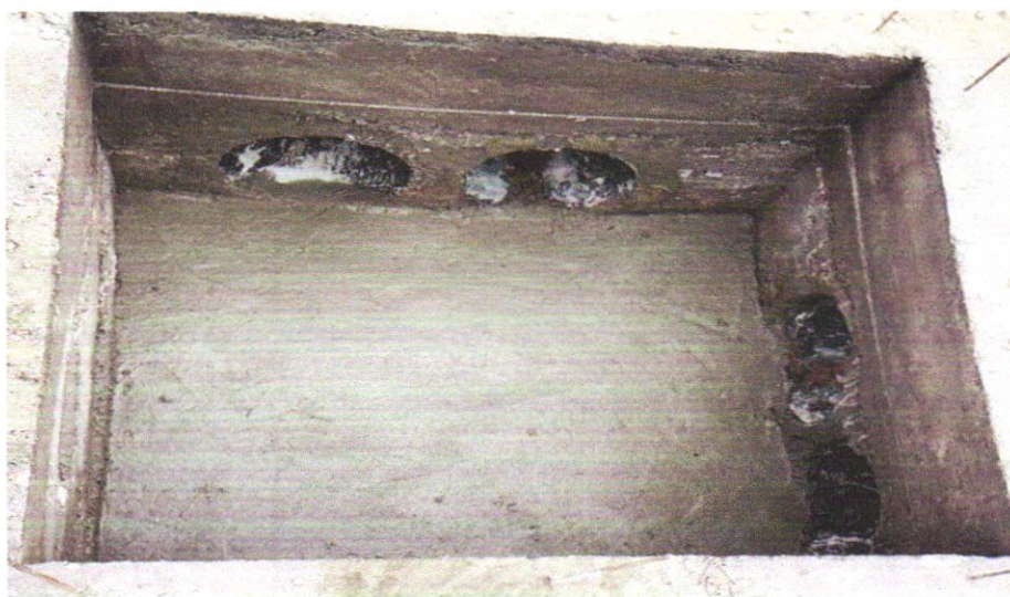
FOTO 04- CONCRETO FCK = 25MPA, TRACO 1:2,3:2,7 (EM MASSA SECA DE CIMENTO/ AREIA MÉDIA/ BRITA 1) - PREPARO MECÂNICO COM BETONEIRA 600 L.
