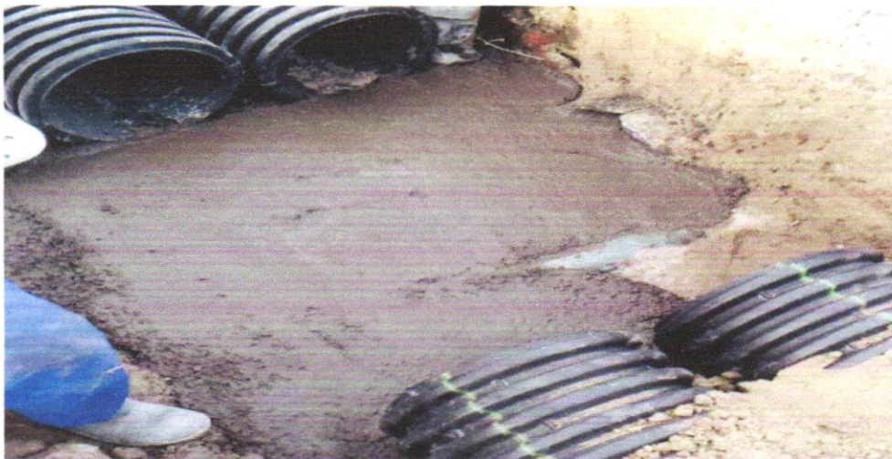
FOTO 01 – LASTRO DE CONCRETO, E=5CM, PREPARO MECÂNICO, INCLUSOS LANÇAMENTO E ADENSAMENTO
